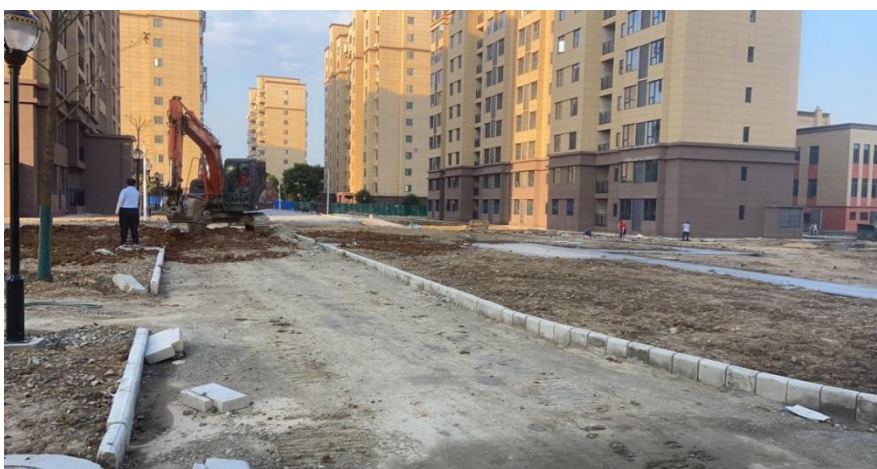
图 2-29 张敏参与随州市向阳棚改二期工程
